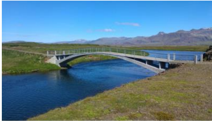
Mynd 24: Vegminjar, brú yfir Haffjarðará (byggð 2012 endurbyggð 2011) 48
